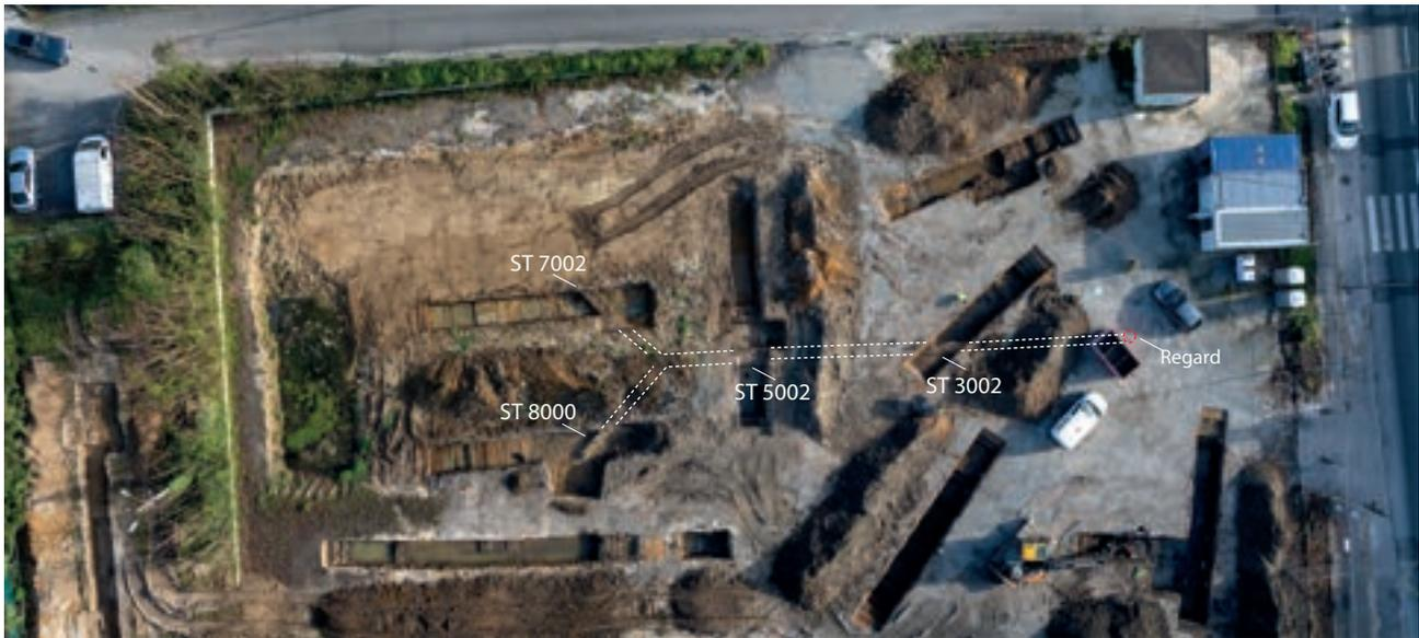
> Fig. 73 : Vue générale des drains ST 3002, 5002, 7002, 8000 (cl. E. Léget)
